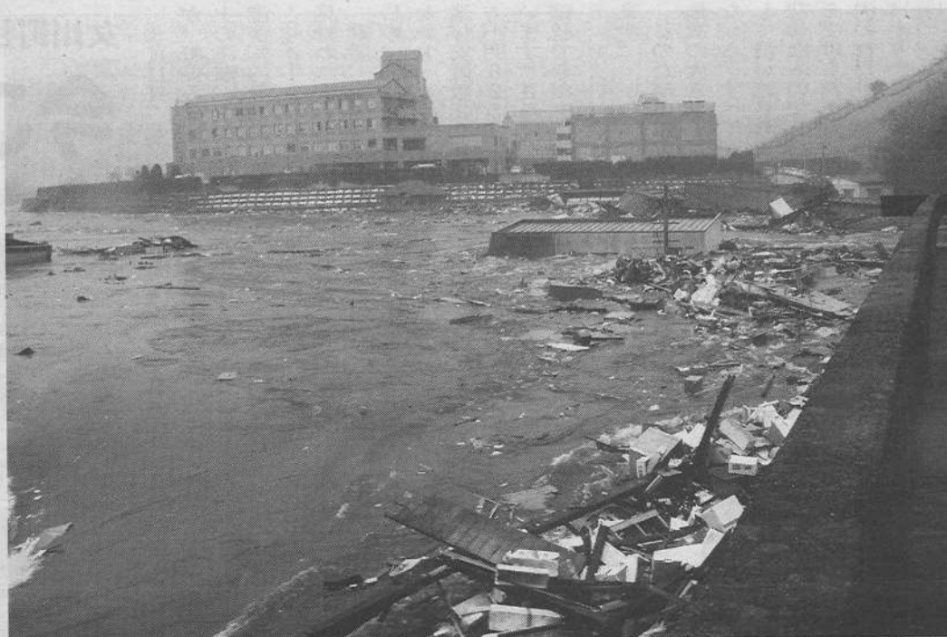
このあと津波は、どんどん水かさを増して、海拔16メートルの地盤に建てられた町立病院の2階までにせまる勢いでした（正面は、町立病院）
